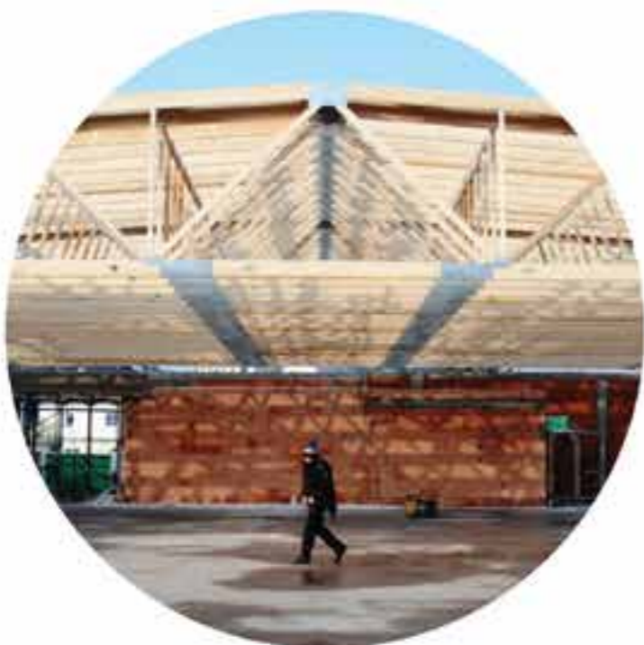
Leseni lamelirani predalčni nosilec (racionalno premagovanje velikih razponov).
