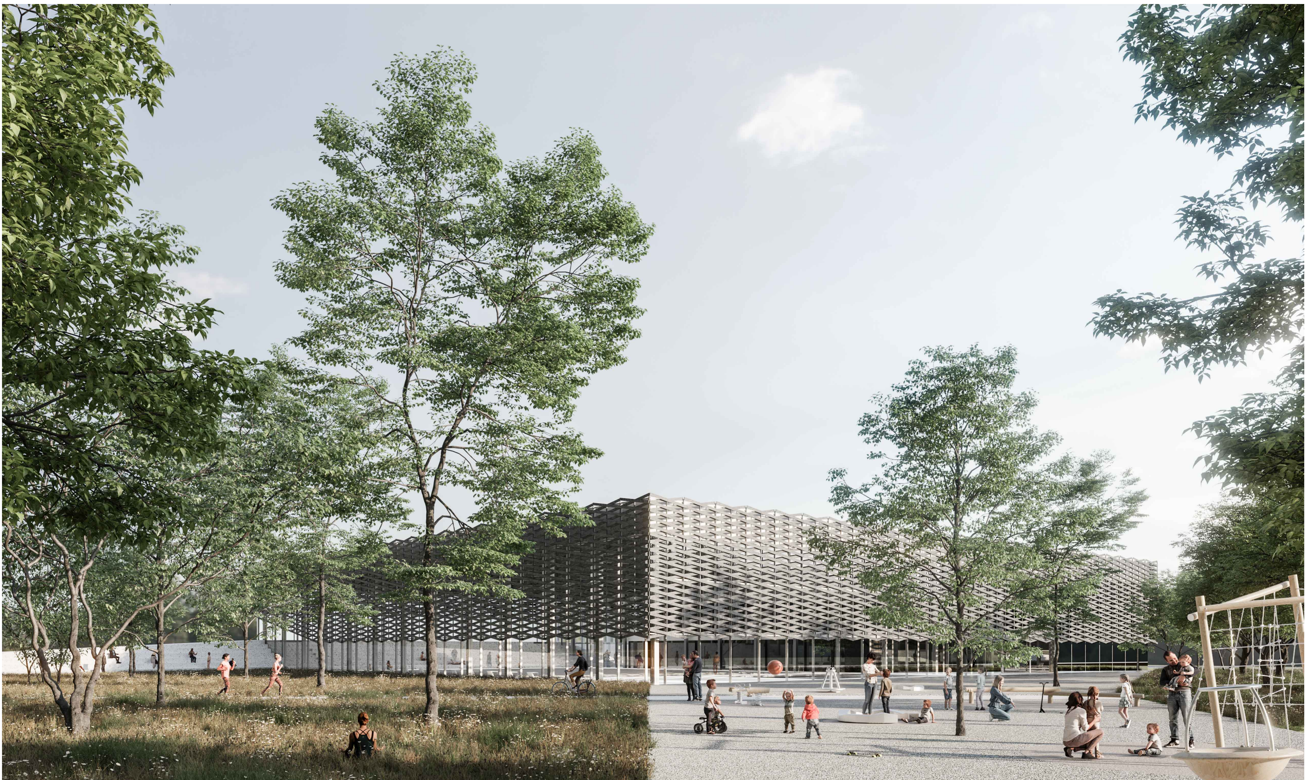
POGLED Z REČNE STRANI NA DVORANO IN PARKOVNO UREDITEV - NAD STEKLENIM PARTERJEM LEBDEČA FASADNA OPNA S STRUKTURIRANO PROSTORSKO MREŽO LESENH BRISOLEJEV SE INTEGRIRA V VEDUTO DREVESNIH KROŠENJ V PARKU
