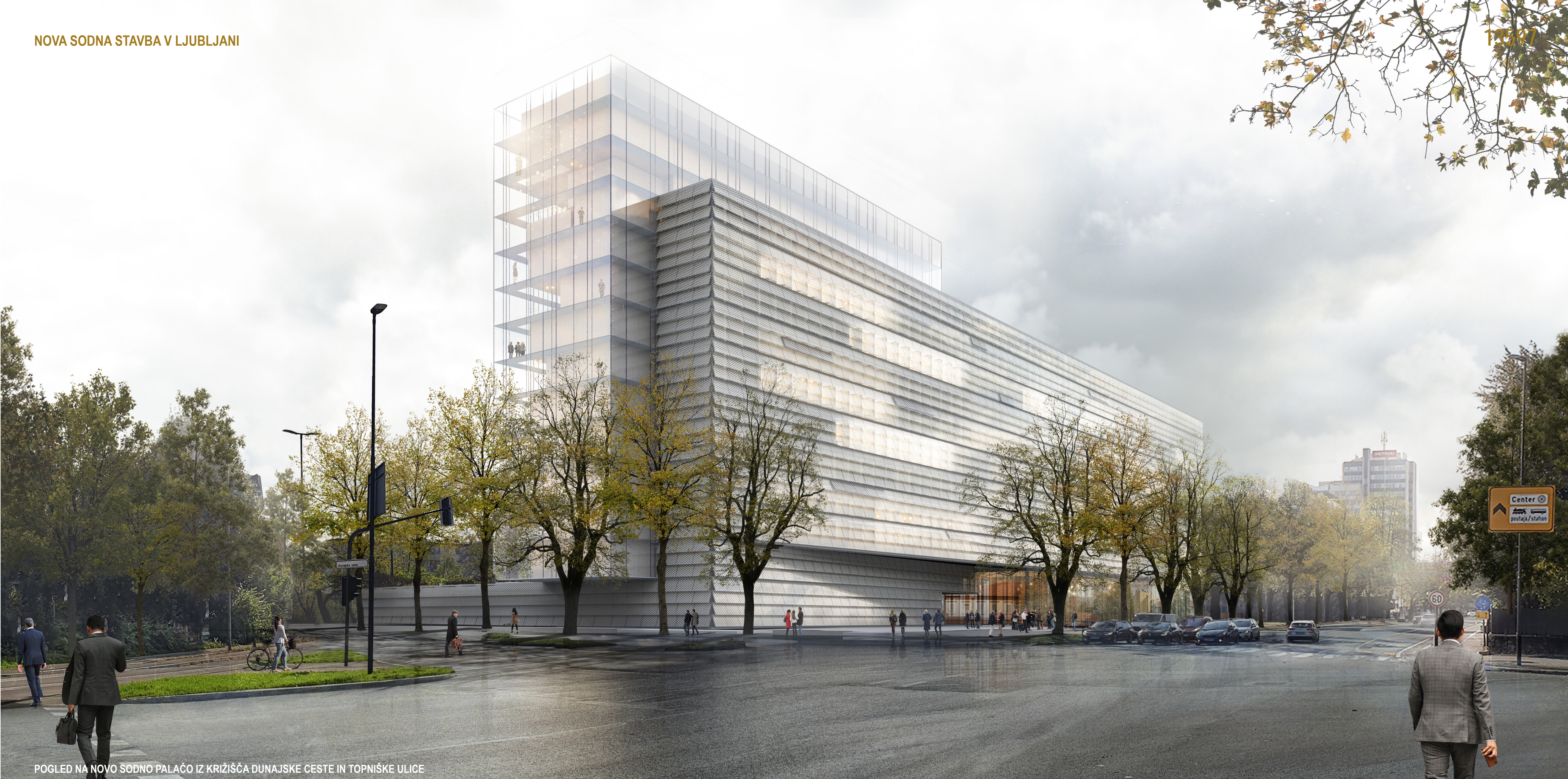
POGLED NA NOVO SODNO PALAČO IZ KRIŽIŠČA DUNAJSKE CESTE IN TOPNIŠKE ULICE
