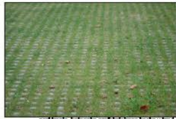
parkiraja_betonaka prelaznicna kocka v travi
