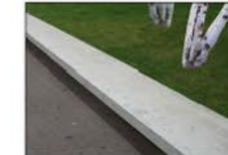
zeleni otok: betonska klop, stol, miza, plato...
