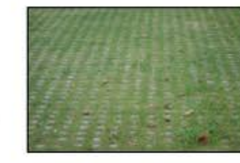
betonske prefabricirane kocke v travi
