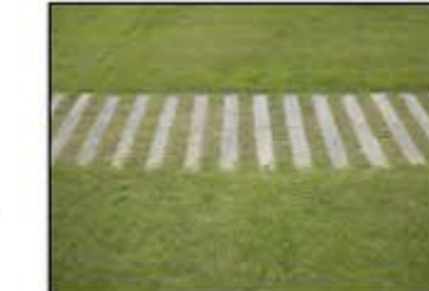
betonski prefabrikati v travi (ureditev poti prl vrtcu)
