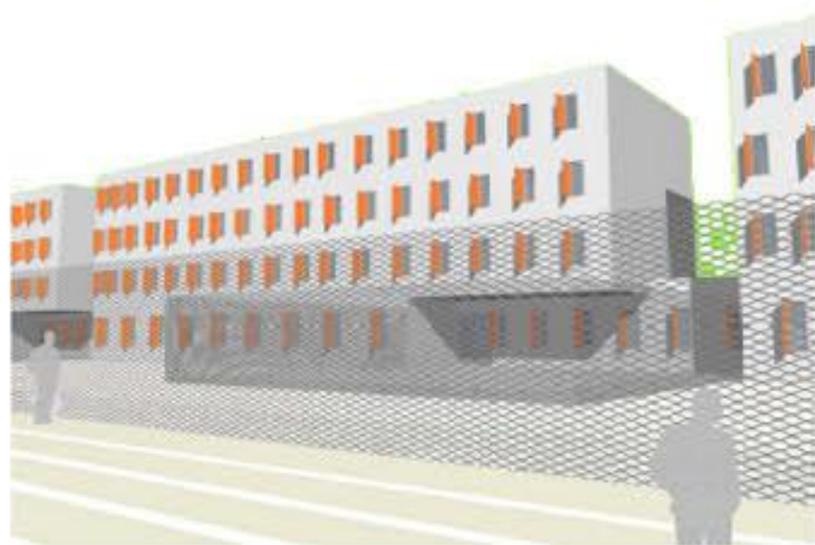
pogled na južno fasado osrednjega objekta
