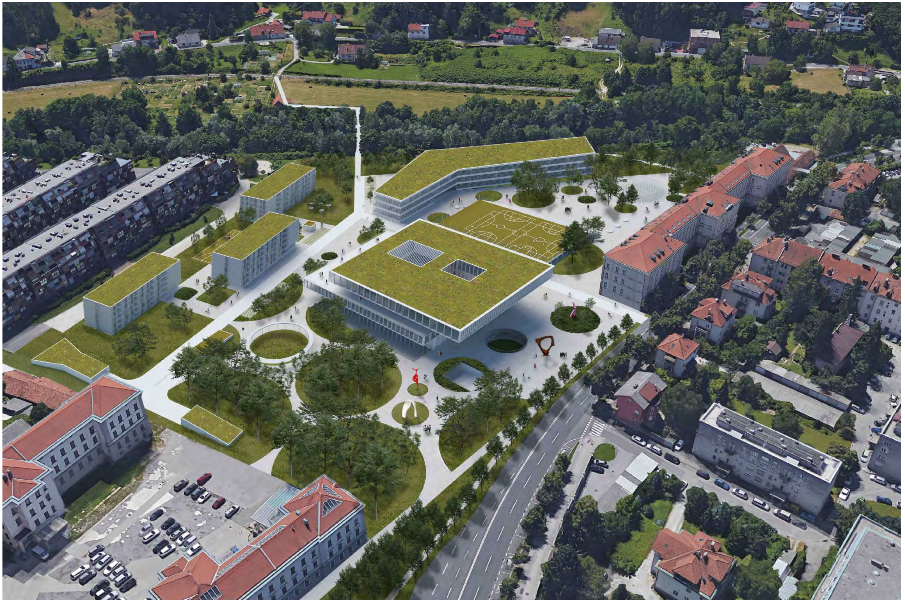
Zračni pogled iz severa na Kampus Roška
