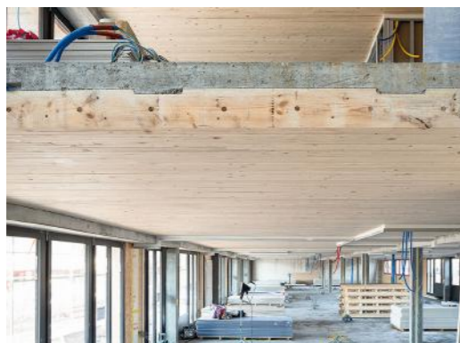
Sovprezna konstrukcija je v primerjavi z sano betonsko bistveno laŹja.
