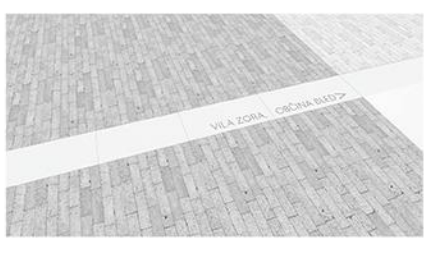
Primer označevanja smeri in pomembnih zgodovinskih obelježij v tlaku - črke iz nesvetlečega nerjavečega jekla vstavljene v mehansko vzdolžljivi granitni kamen - za primer označevanja lokalov glej prostorski prikaz gostinskih vrtov Hotela Park in prikaze fasad
